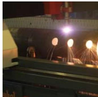
Boru kesim. Pipe cutting.
